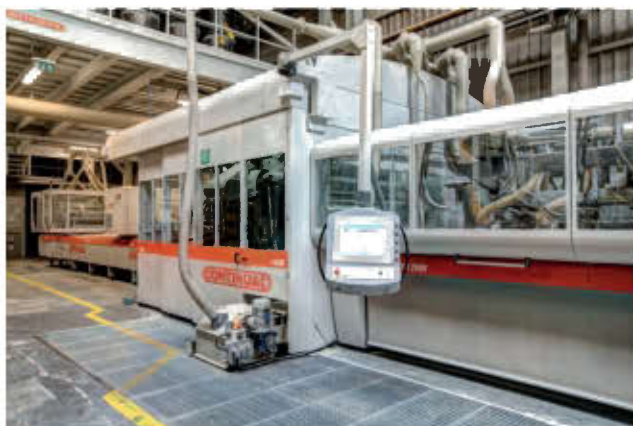
Rys. 2. Widok na ciąg Continua+ z elementami APB, DDD, PCR2000 i TPV.
